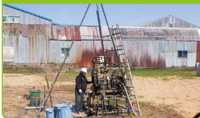
ボーリング調査
