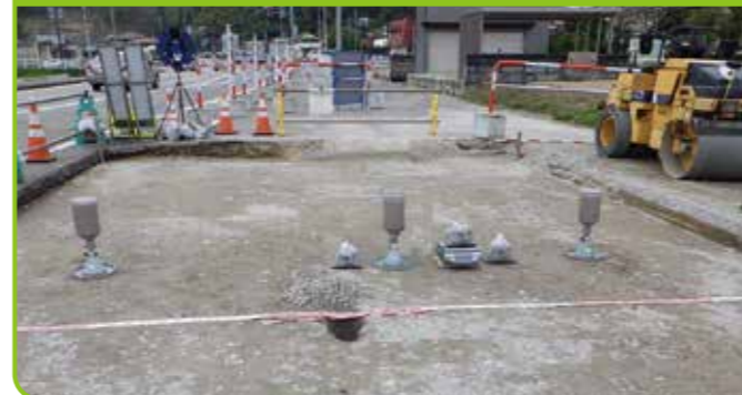
現場密度試験
